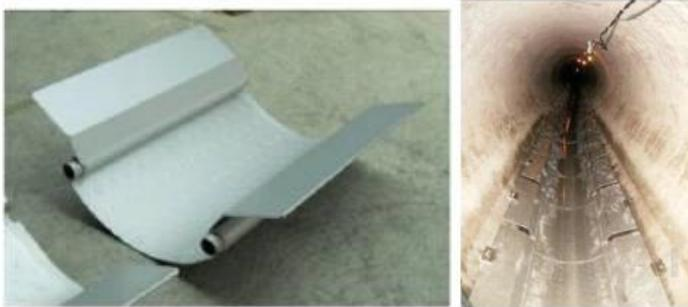
Par exemple, un échangeur de 84 m avec un débit de  $33 \text{ L.s}^{-1}$  est installé à Valenciennes (France). Il apporte 77% des besoins énergétiques de l'hôtel de ville (bâtiment de  $8\,500 \text{ m}^2$ ).
