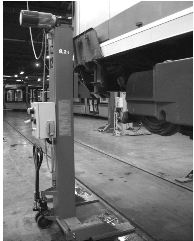
Photo 4 : Colonne d'extrémité en phase de levage
